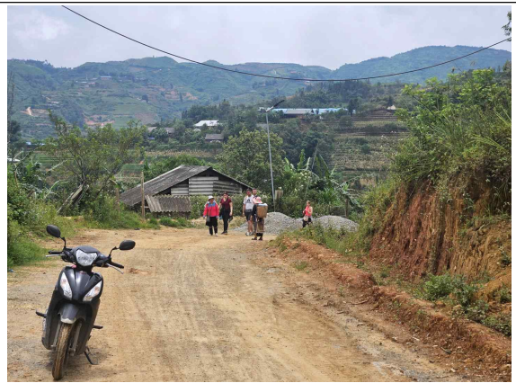
나의 두 발이 되어준 오토방구와 공사 중이었던 마을길
