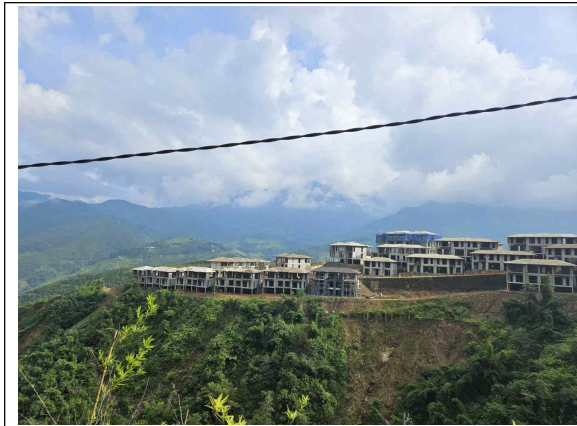
이런 식의 콘도가 계단 눈이 보이는 산등성이 위 곳곳에서 공사 중이었음
